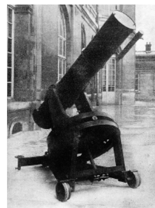
TELESCOPIO CON CONFIGURACIÓN COUDE-CASSEGRAIN
